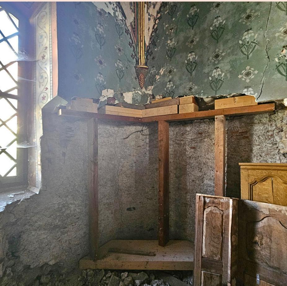
Mise en sécurité des voûtes après apparition de fissures traversantes et affaiblissement des murs des deux chapelles. La présence de mérule conditionne l'étalement en partie basse
