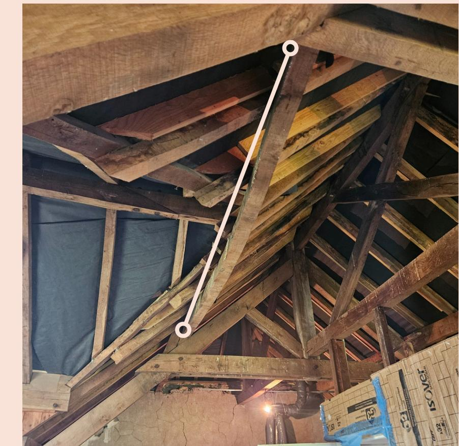
Les modifications de la charpente ont provoqué un déplacement excessif de la panne supportant le chien-assis. Nous assurons le dimensionnement des renforcements en charpente bois, incluant les plans d'exécution et la note de calcul, afin de consolider localement la structure. Un suivi de chantier est également prévu pour contrôler la bonne mise en œuvre.
