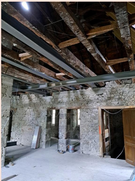
Dimensionnement des sommiers béton réalisé par l'entreprise SELE. Réalisation de plans d'exécution et note de calcul. Le renforcement des planchers fait suite à la volonté du maître d'ouvrage de transformer la grange ci dessous en salle de danse.
